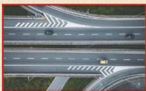
రోడ్ల నిర్మాణం/విస్తరణ (10 ప్రాజెక్టులు) రూ. 4,593 కోట్లు
